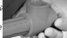
**5** Аккуратно извлеките трубу и фитинг из сварочного аппарата и вставьте трубу в фитинг. При стыковке не рекомендуется вращать их относительно друг-друга. Для обеспечения необходимой точности (угловые фитинги) рекомендуется воспользоваться дополнительной оснасткой.
